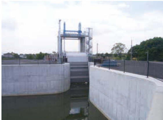
工事名：河川工事（流入施設Ⅲ期工その2）
