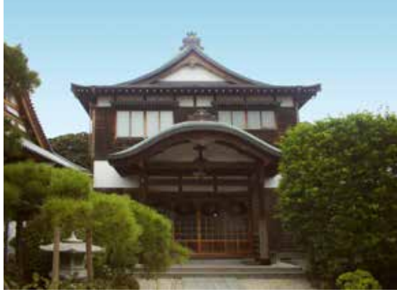
工事名：宗教法人天嶽寺客殿工事
