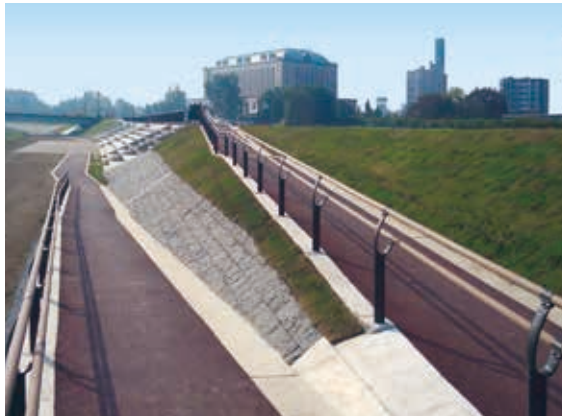
工事名：水辺再生100プラン推進工事 (遊歩道整備工)
