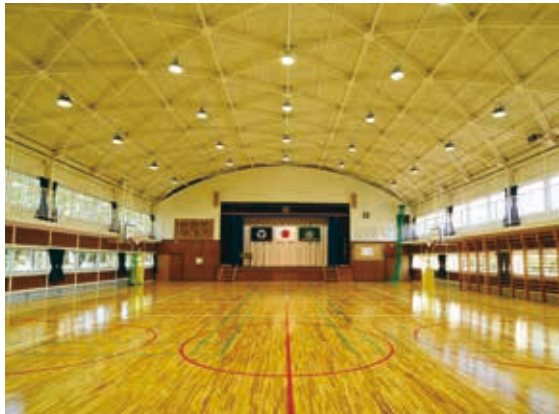
工事名：三郷市立桜小学校屋内運動場 耐震改修工事
