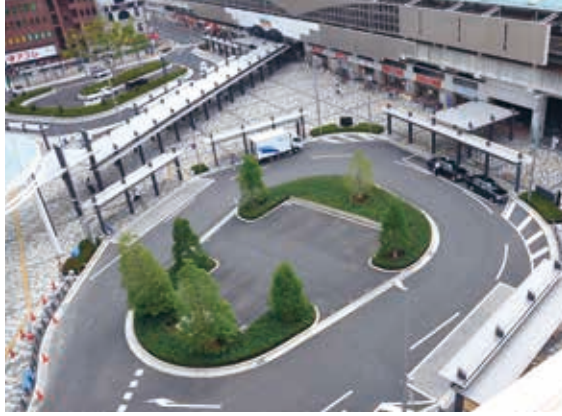
工事名：越谷駅東口第一種市街地再開発事業 駅前交通広場整備工事
