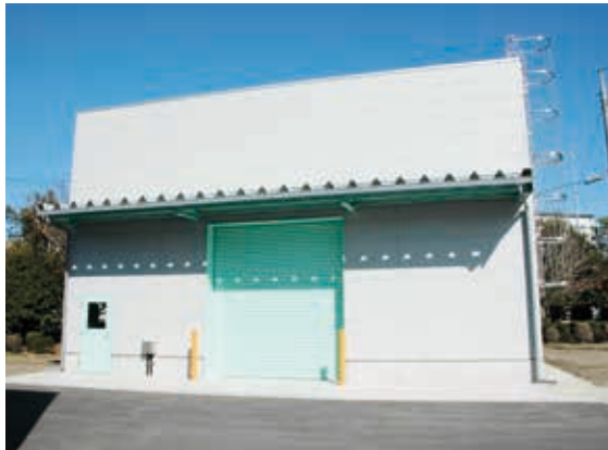
工事名：中川流域処理場汚泥系機材庫 築造建築工事
